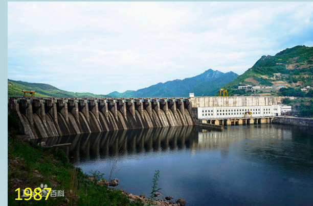
Weiyuan HPP , 390MW 0.9TWh/Y
